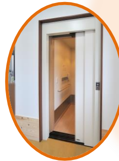
▲エレベーター
